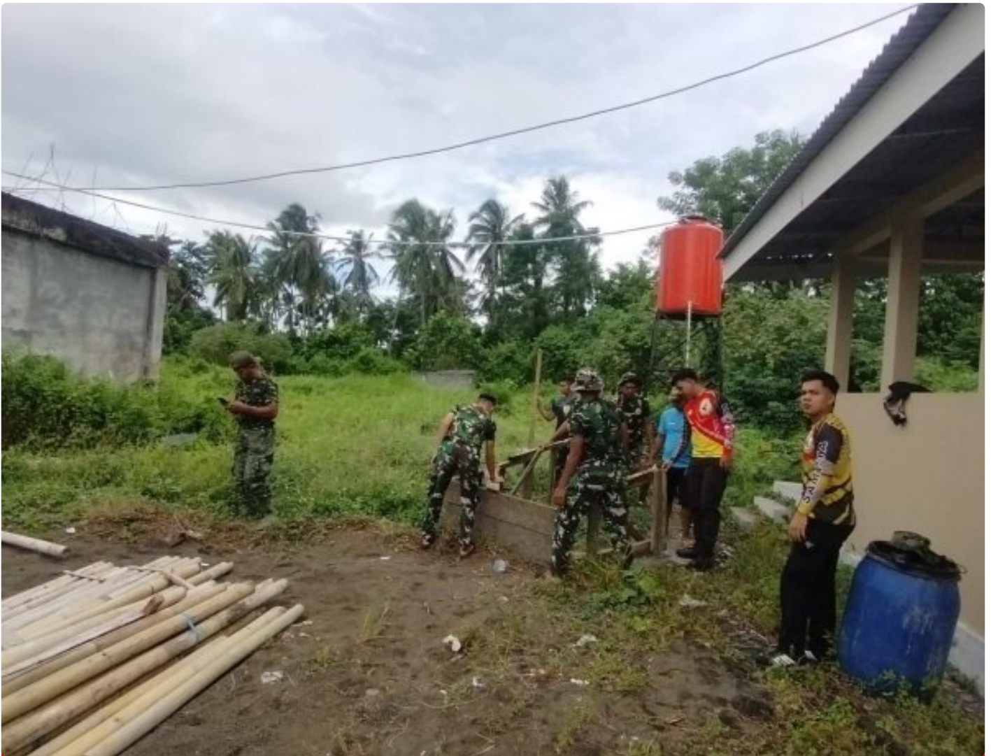
Satgas TMMMD Ke-123 Kodim 1310 Bitung lakukan pekerjaan Rehab ruang kelas Panti Asuhan Hidayatullah Bitung
