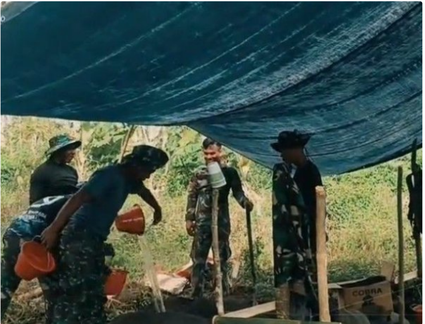
Pekerjaan Pembangunan Bak Penampung Air Bersih oleh Tim Work Satgas TMMD Ke-123 Kodim 1310 Bitung
